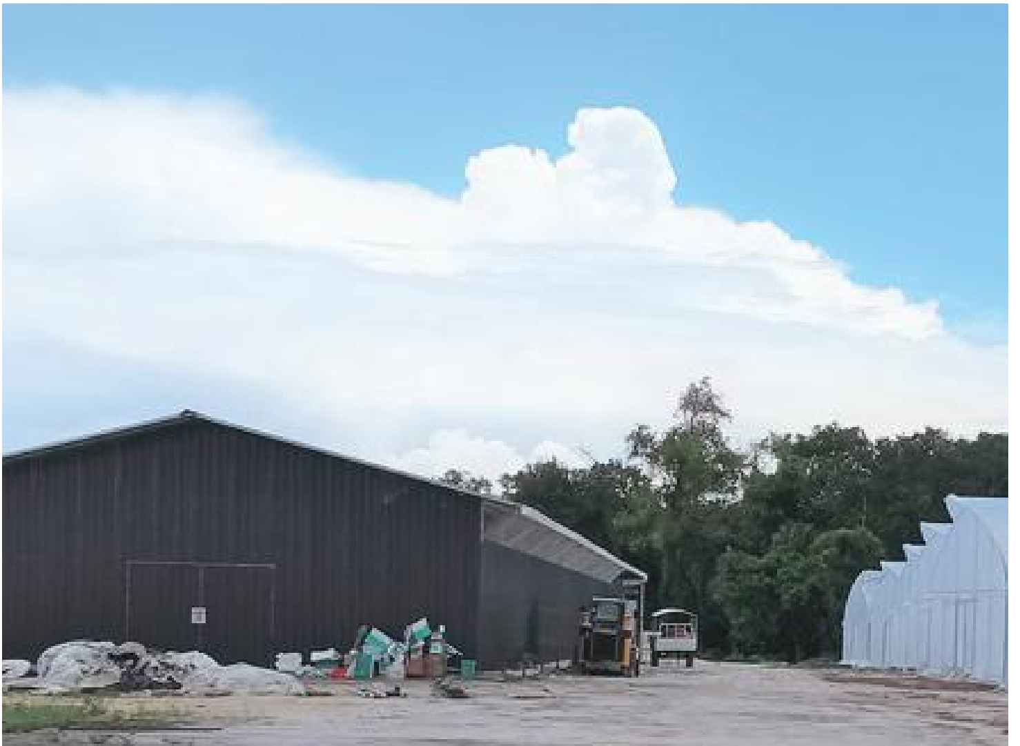
Bangunan berwarna hitam adalah bagi menempatkan kemudahan pam air The black building on the left is for the pump house
